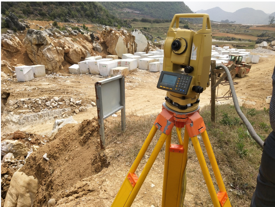
图 2-5 荒料临时堆场
